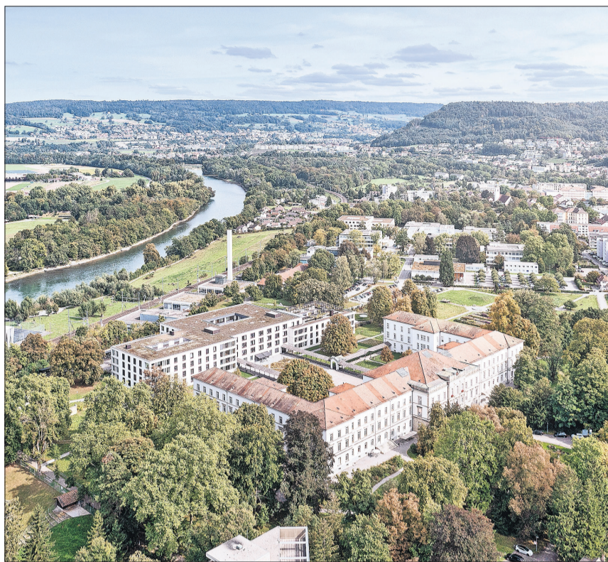
Das Hauptgebäude der PDAG ist wunderschön gelegen auf dem Areal Königsfelden an der Zürcherstrasse in Windisch. Inmitten eines naturnah gestalteten Parks hat es Jahrhunderte überdauert und vermittelt ein starkes Gefühl von Sicherheit und Kontinuität.
