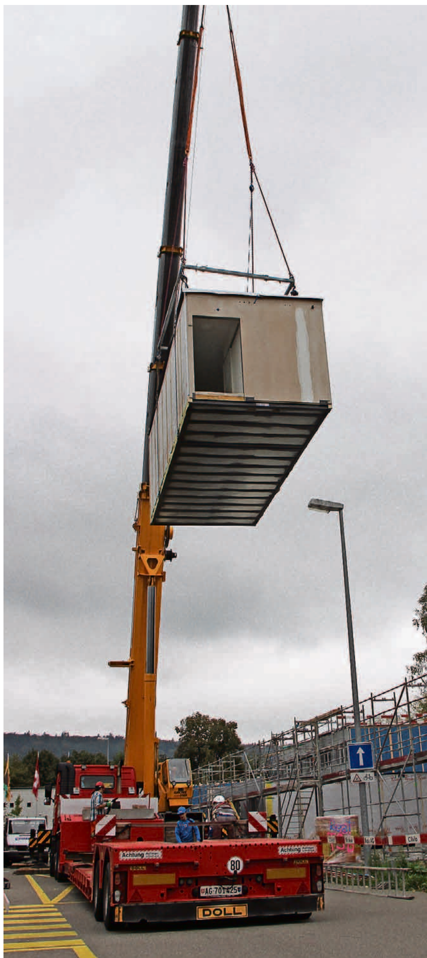
Kran transportiert ein Modul für die neue Kriseninterventionsstation auf dem Areal der Psychiatrischen Klinik Königsfelden.
